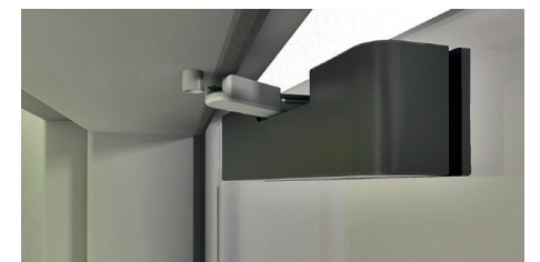
Beim Schließen der Tür läuft der Hebelarm auf den Zapfen an der Zarge auf, stützt sich auf diesem ab und hält die Tür in der Schließposition.
