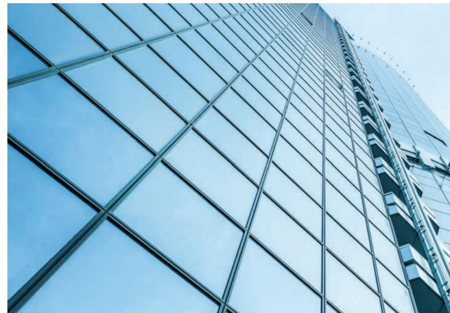
Beide lassen weniger als 1/3 der Sonnenenergie und etwa die doppelte Menge Licht durch. Die Außenreflexion von Grau 61/32 beträgt lediglich 9 % und ist damit die niedrigste unserer Sonnenschutzglas-Palette. Bei dem brillanten Typ 60/31 beträgt die Außenreflexion 11 %. Diese niedrig reflektierenden Sonnenschutzgläser haben beste Sonnenschutzfunktionen und sind aktuellster Stand der Technik.
