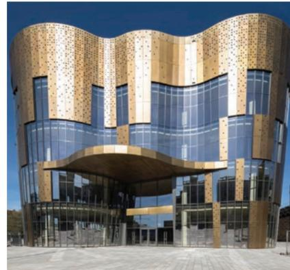
dämmten Unterkonstruktion und aus einer Bekleidung mit vorbrünierten und lackierten Kupfer- bzw. Kupferverbundtafeln. Die Pfosten-Riegel-Fassaden erhalten großflächige Verglasungen.
