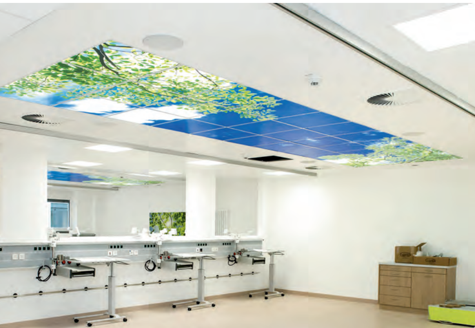
Unter Wolken entspannen können dank an der Decke montierter Lichtpaneele die Patienten der Rhön-Klinikum AG im Neubau des neuen Campus Bad Neustadt.
