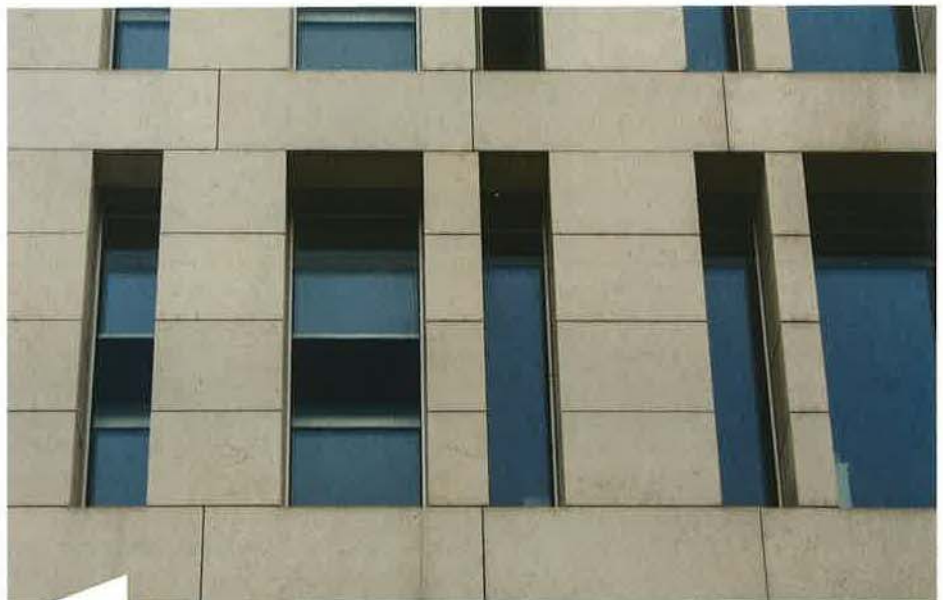
Unschön ist bei der DIN 18008-2, dass das Problem „handtuchformatiger“ 3-fach-Isoliergläser ab ca. 0,85 m kurzer Kantenlänge beginnt. Ein großer Teil dieser ISO lässt sich unter Norm-Randbedingungen nicht mehr nachweisen. Hier sind ortshöhenindividuelle Bemessungen oder vorgespannte Glasarten erforderlich.
