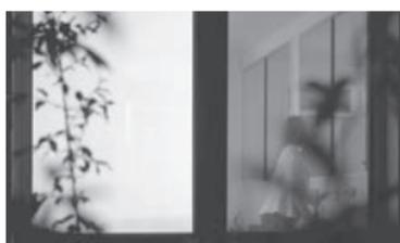
Tagsüber bzw. im ungeschalteten Zustand sind die Laserpunkte kaum zu erkennen (oberes Bild). Nachts erstrahlen sie im geschalteten Zustand (linke Seite des mittleren Bilds sowie unteres Bild). Damit gelangt nicht nur tagsüber Licht durch das Glas in den Raum, sondern auch nachts über die Leuchtscheibe, was gleichzeitig den Sichtschutz bewirkt (rechte Seite des unteren Bilds).
