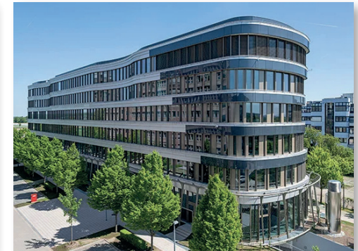
Die neue Fassade nach Sanierung
