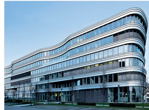
Das Bestandsgebäude vor Sanierung
