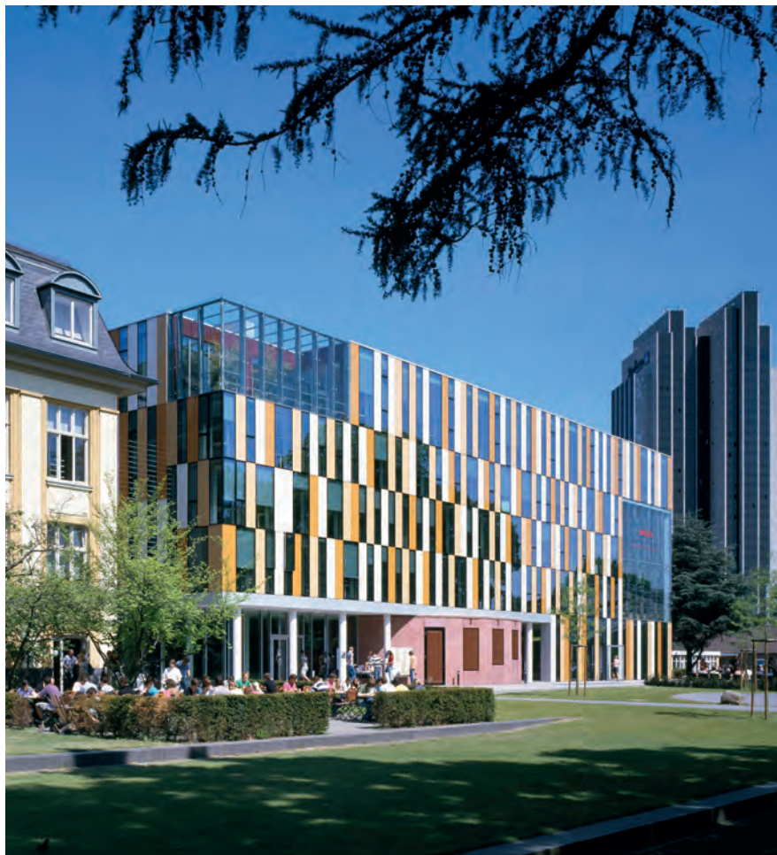
Die DELOGCOLOR® Fassadenplatten im Anbau der Bucerius Law School, Hamburg nimmt die Farben des Altbaus auf und schafft eine optische Verbindung beider Gebäudeteile.
